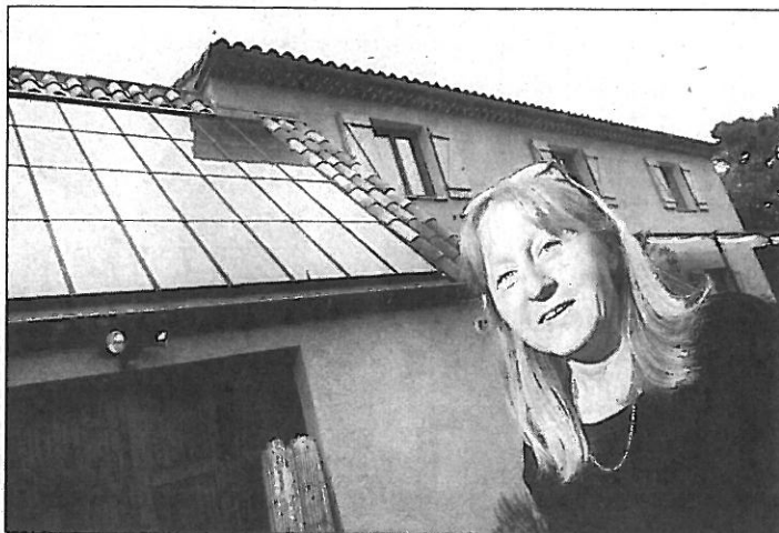
18 m 2 de capteurs solaires pour chauffer 240 m 2 de maison. J.-M. MART
